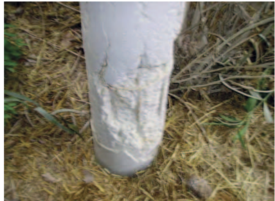
Particolare base del pilastro
