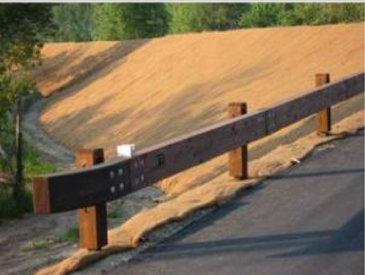
Sistemazione della barriera in legno e acciaio
