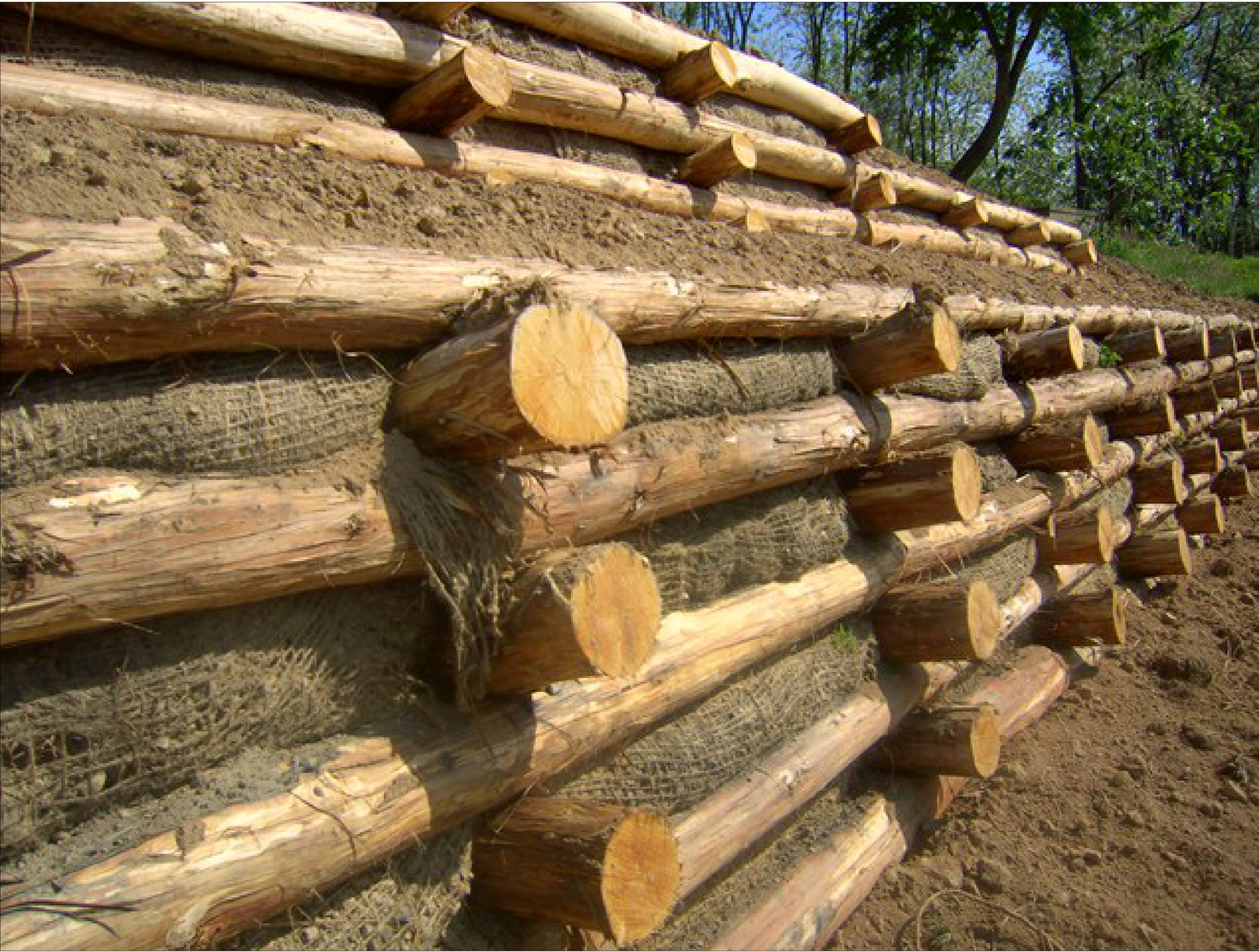
Visuale della geometria della palificata doppia
