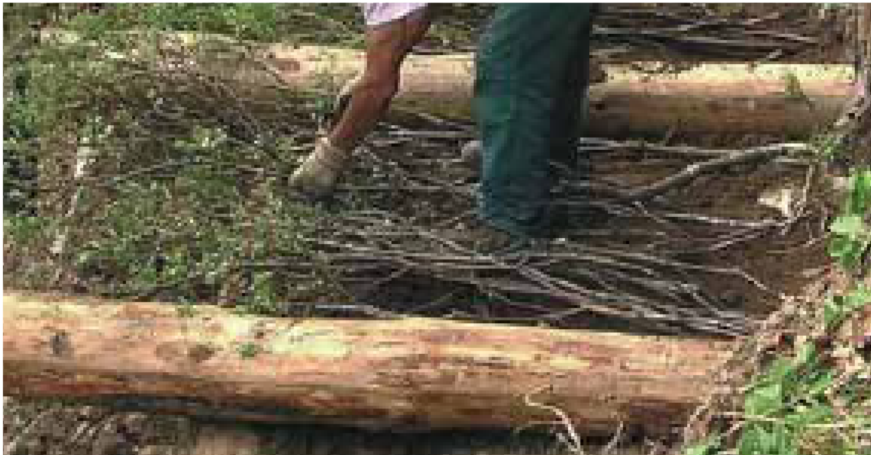
Disposizione delle talee nella struttura
