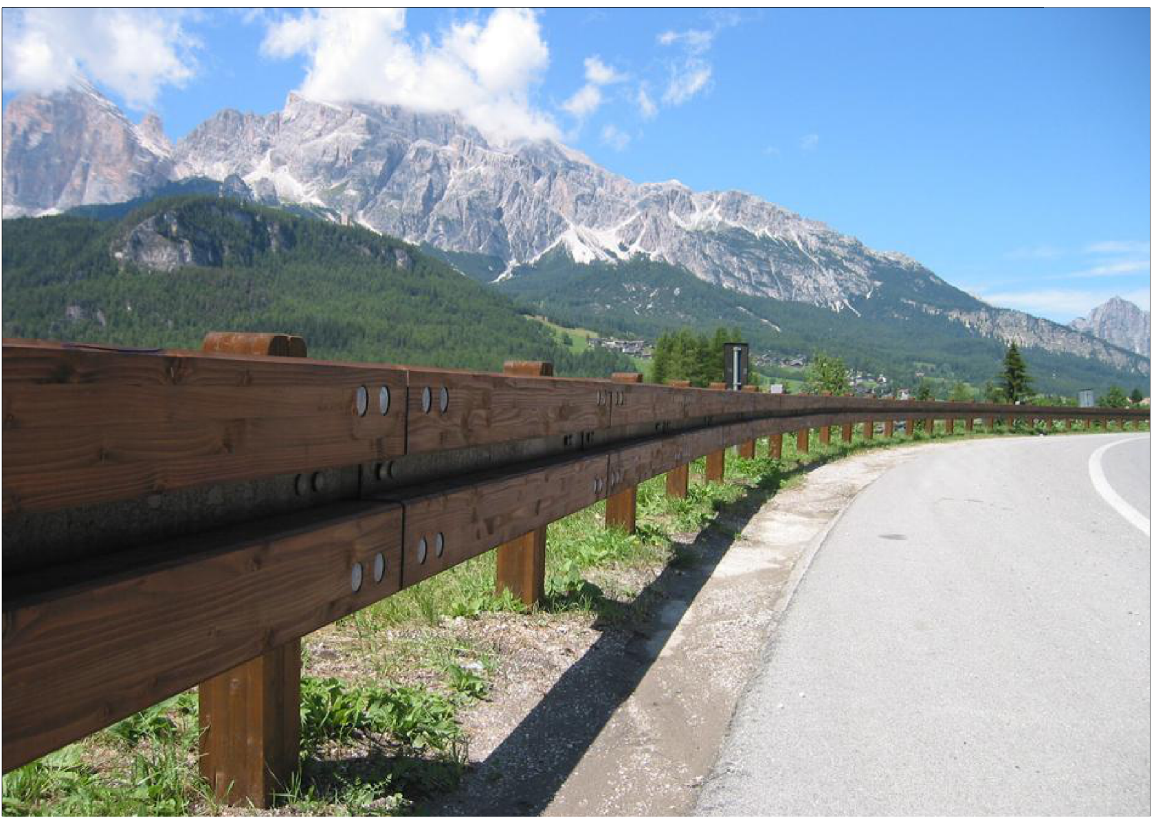
Sistemazione della barriera in legno e acciaio
