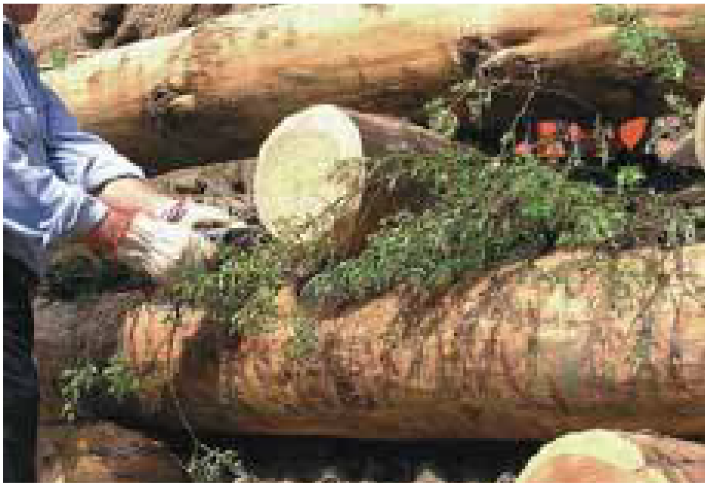
Disposizione delle talee nella struttura
