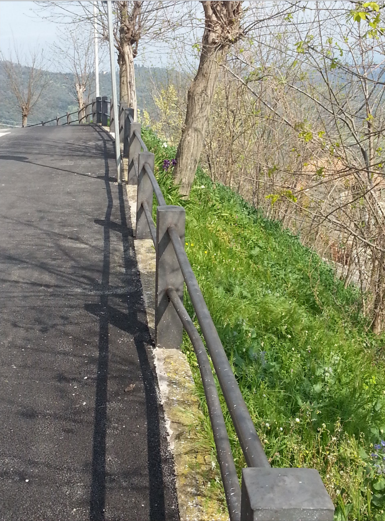
Figura 5: corrimano e cordolo perimetrale di piazza dell'Indipendenza.
