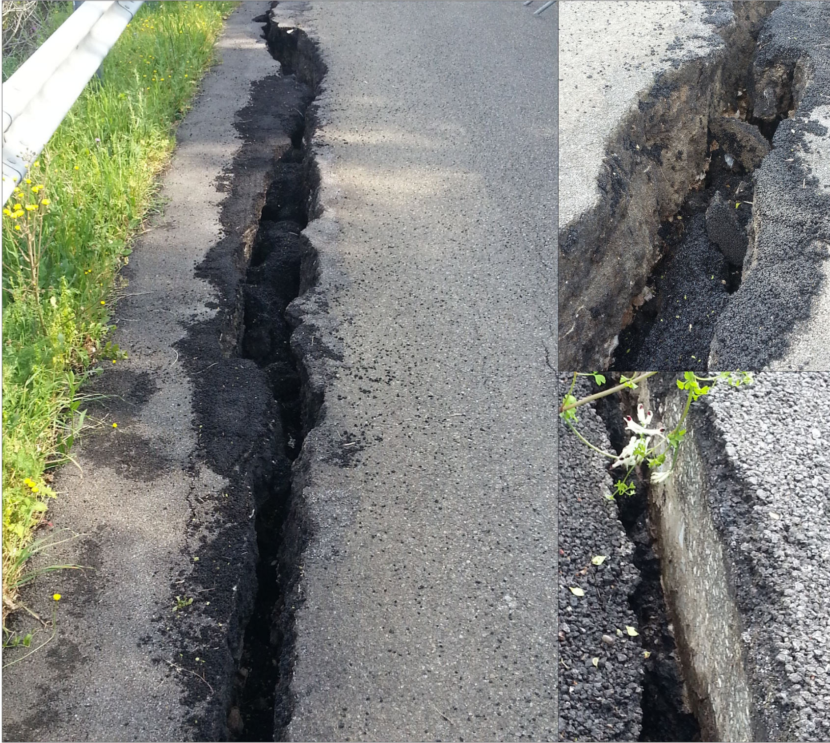
Figura 9: grave fessurazione del manto stradale (ampiezza max 30cm).
