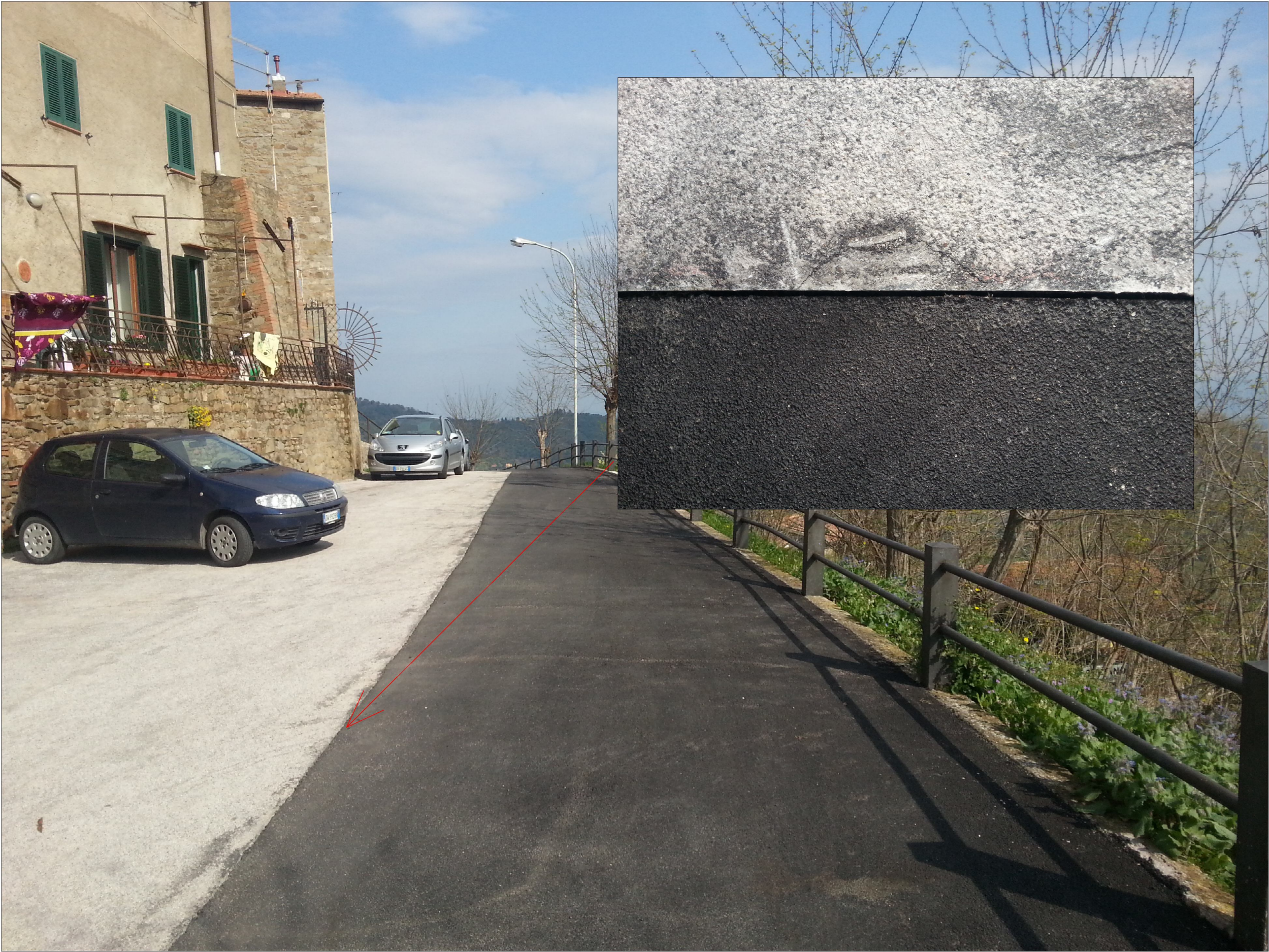
Figura 3: stato di fatto della pavimentazione di piazza dell'Indipendenza. Nel riquadro particolare della fenditura fra pavimentazione nuova (in basso) e quella preesistente (in alto).
