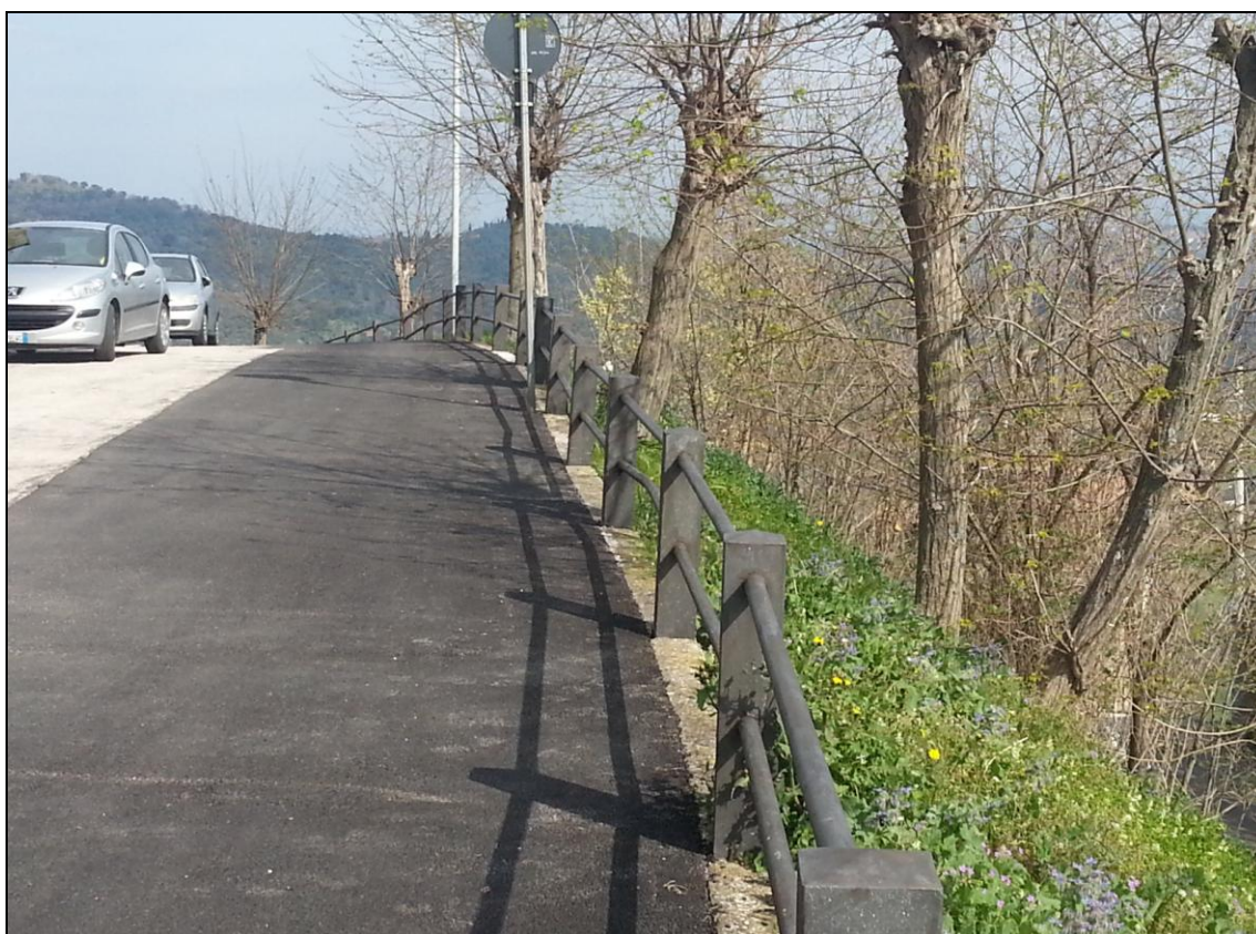
Figura 2: avvallamenti e rotazione della ringhiera protettiva nell'area d'intervento 1.
