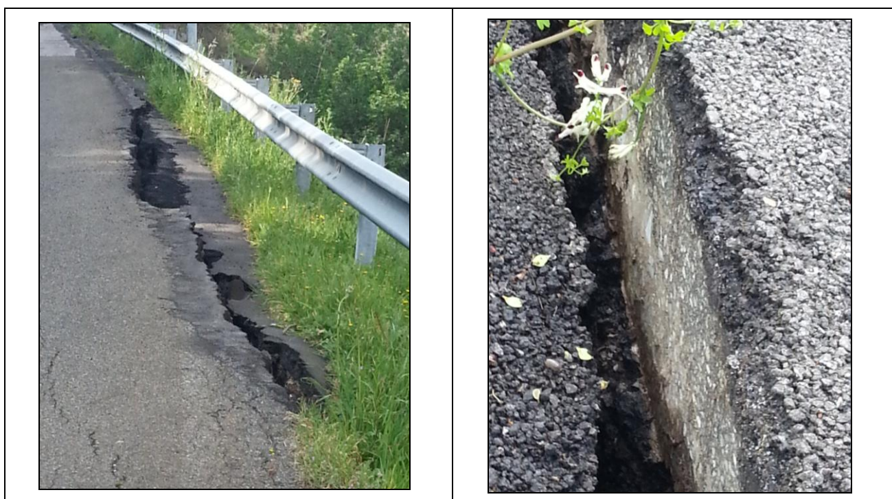
Figura 3: fenditura sul manto stradale nell'area d'intervento 2.
