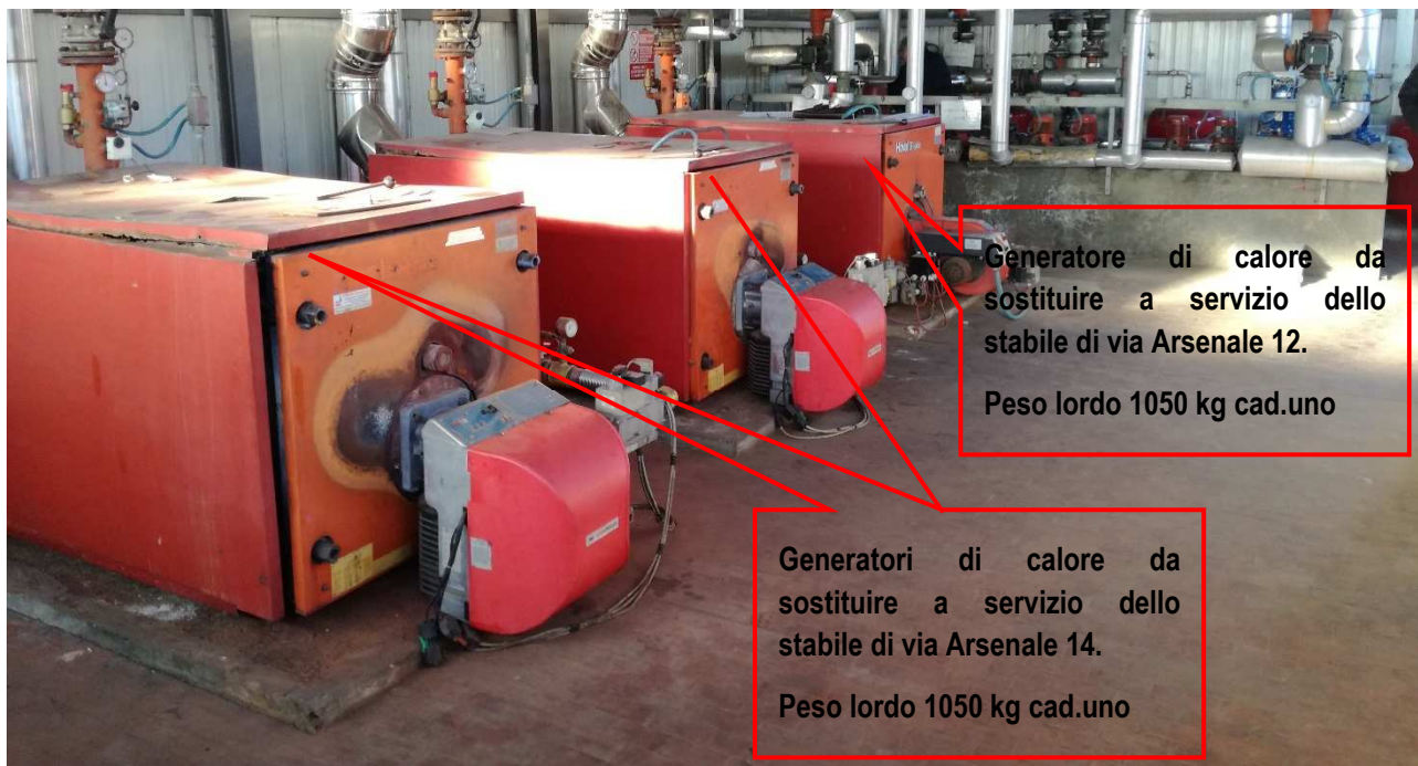
Figura 2 – Caldaie esistenti da smantellare
