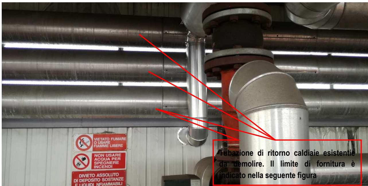
Figura 8 – Tubazioni di ritorno caldaie esistenti da demolire.
