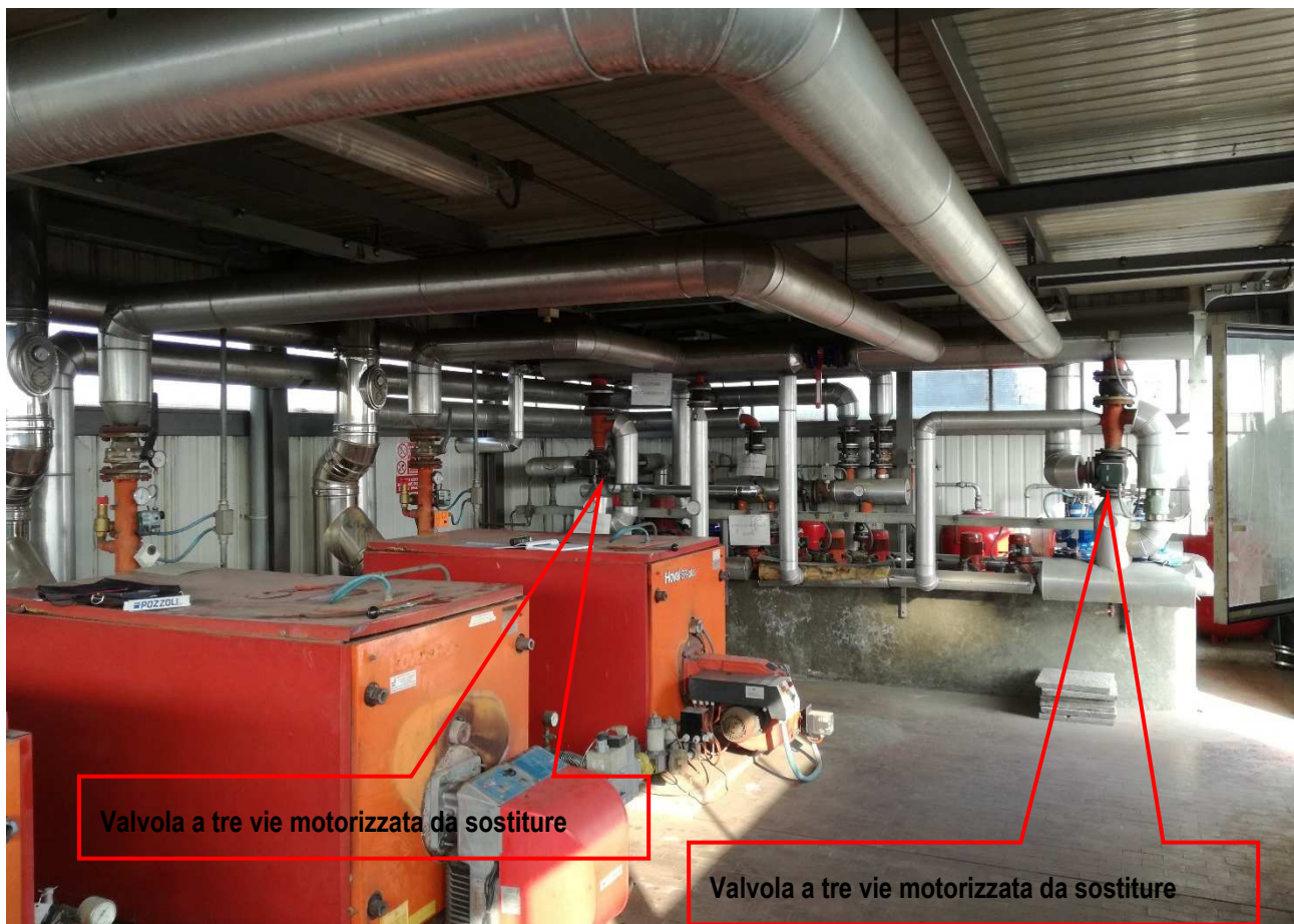
Figura 13 – Valvole a tre vie motorizzate da smantellare e sostituire con valvole di uguali caratteristiche.
