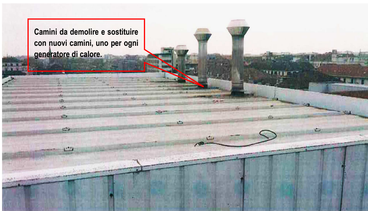
Figura 5 – Camini esistenti da demolire e sostituire con nuovi camini, ripristinando la faldaleria della copertura.
