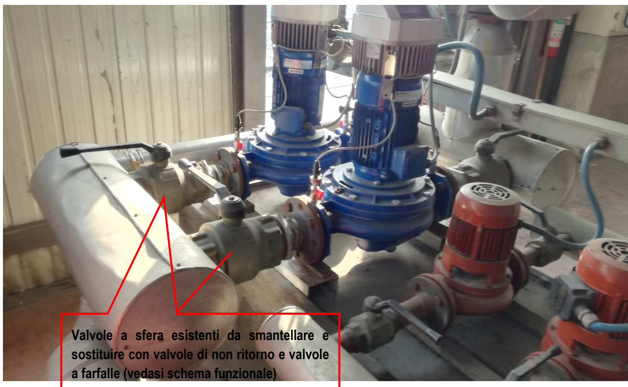
Figura 11 – Pompe esistenti a servizio dei circuiti secondari dello stabile di via Arsenale 14.
