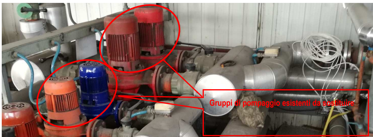
Figura 12 – Gruppi di pompaggio dei circuiti secondari dello stabile di via Arsenale 12 da sostituire.
