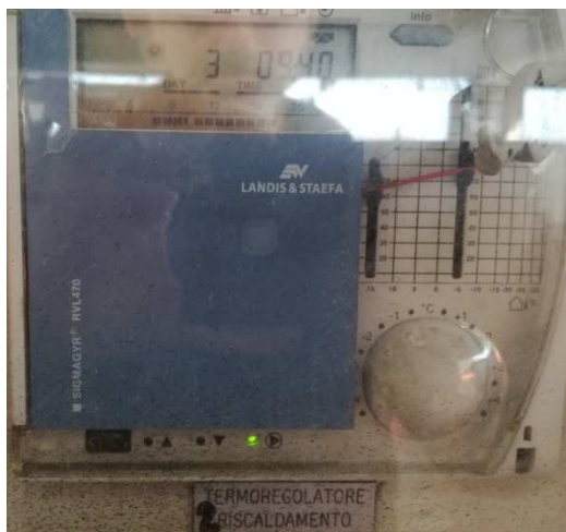
Figura 19 – Vecchio regolatore con curva climatica (Edificio Via Arsenale 14) da programmare nella logica a controllo della nova centrale
