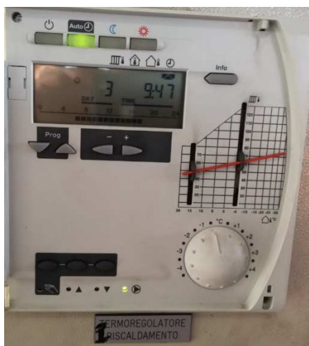
Figura 20 – Vecchio regolatore con curva climatica (Edificio Via Arsenale 12) da programmare nella logica a controllo della nova centrale
