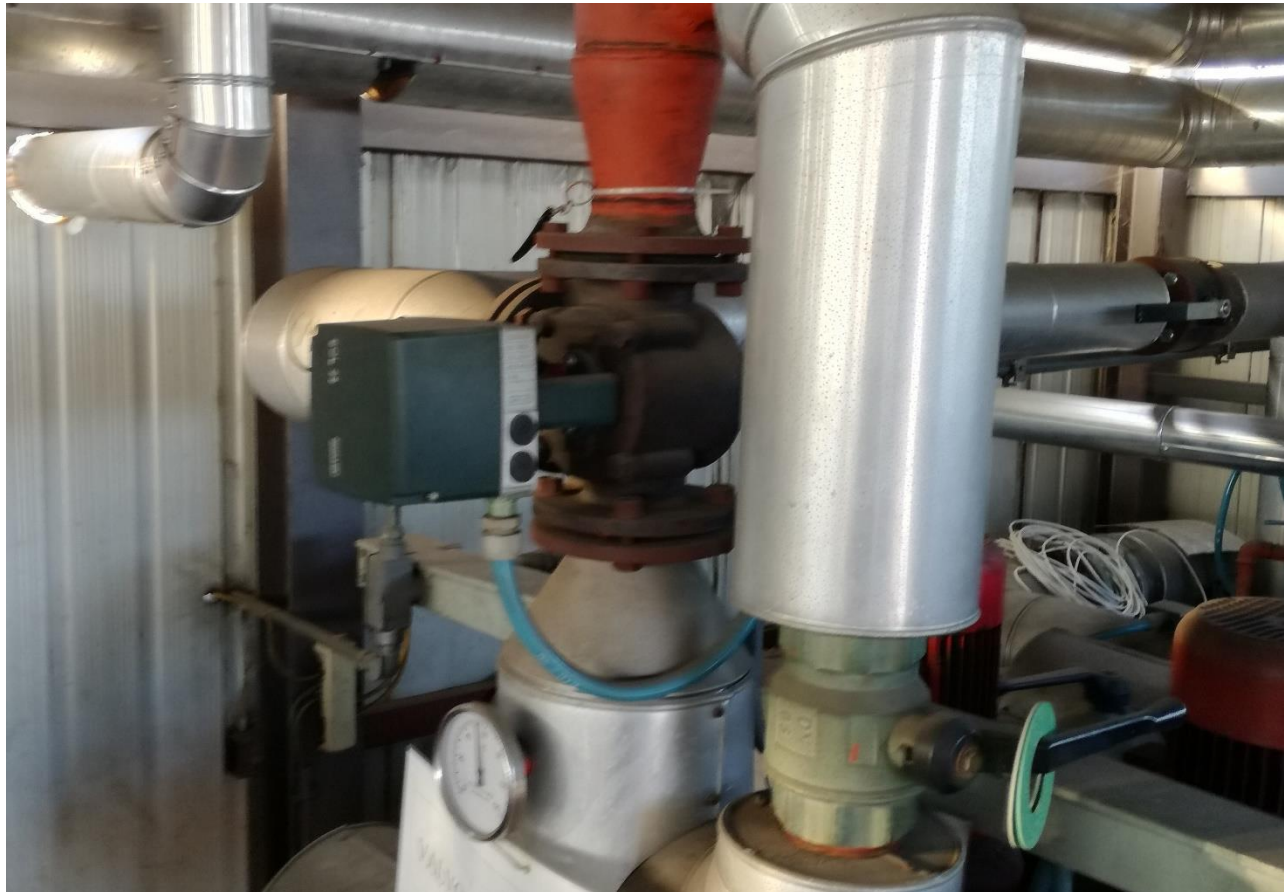
Figura 25 – Valvola a tre vie a servizio circuiti miscelati edificio Via Arsenale 12
