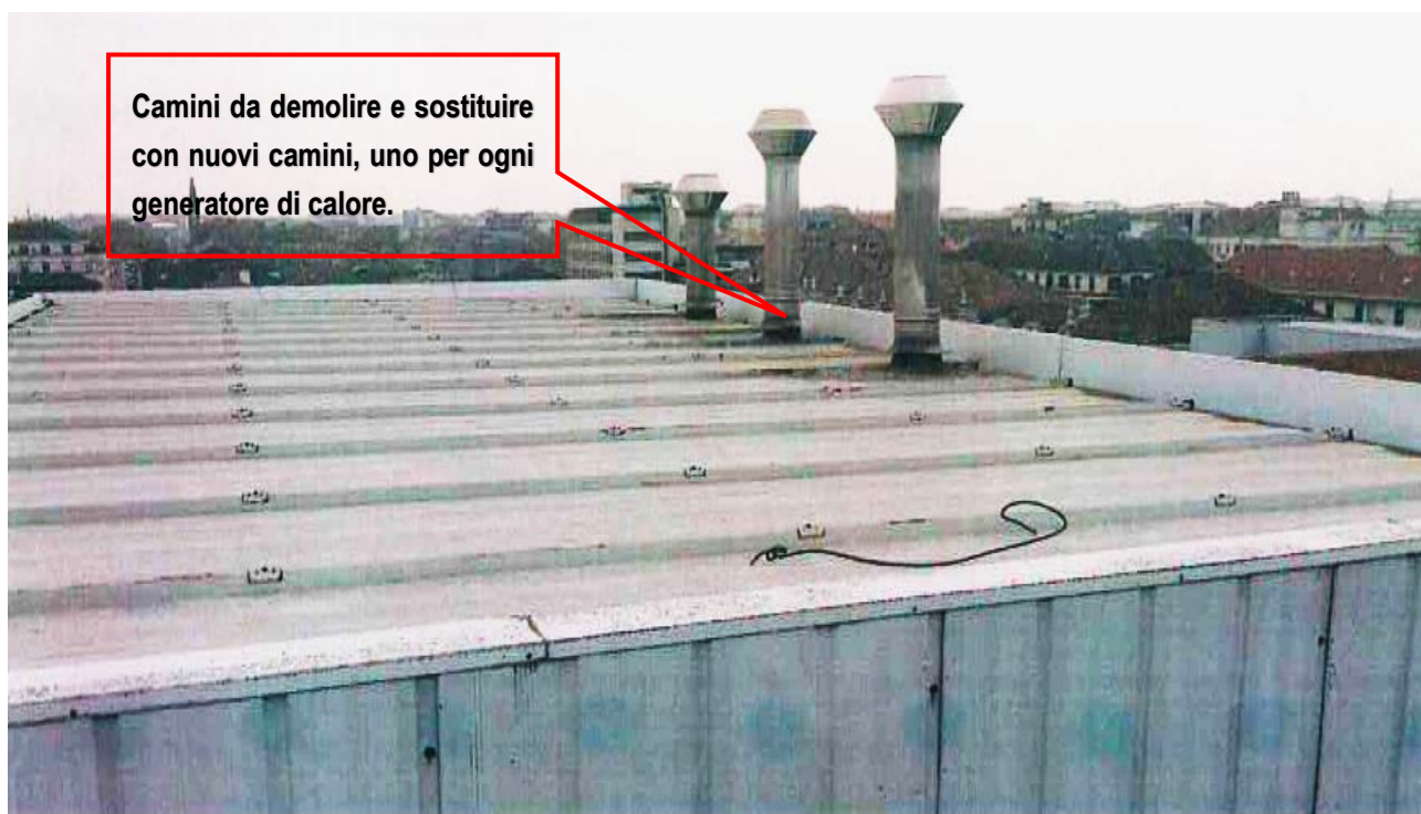
Figura 4 – Camini esistenti da demolire e sostituire con nuovi camini, ripristinando la faldaleria della copertura.
