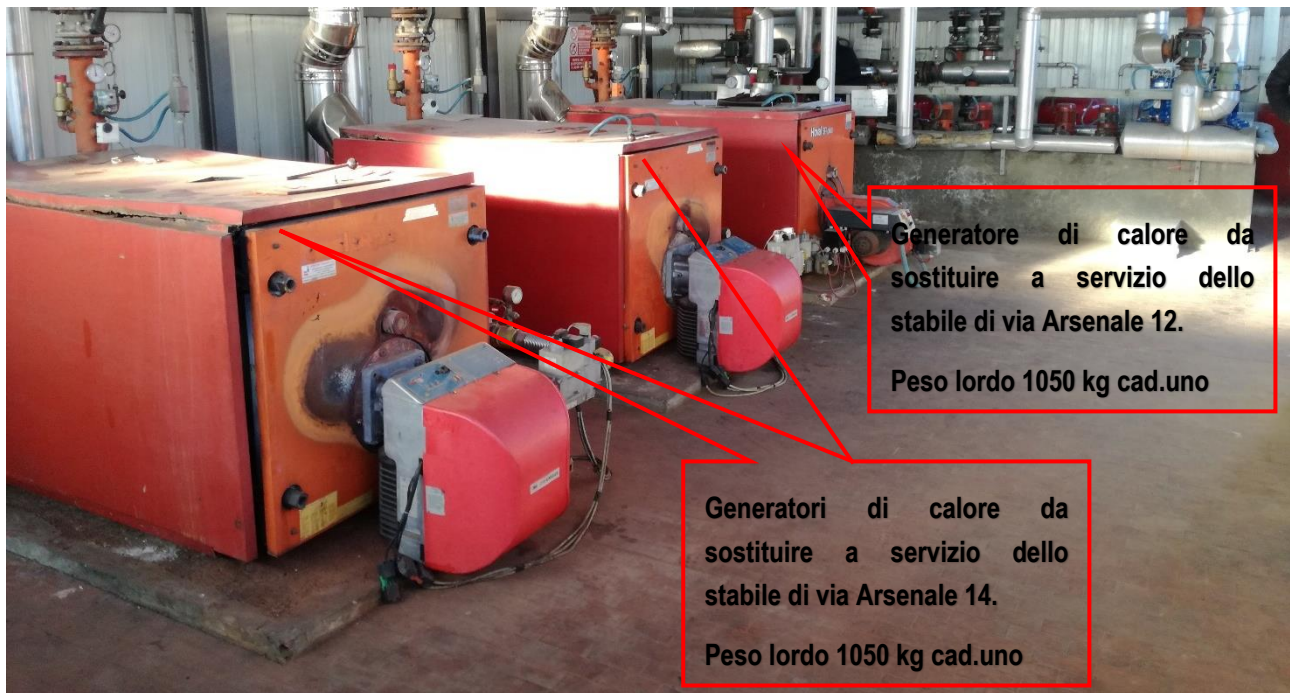
Figura 1 – Caldaie esistenti da smantellare
