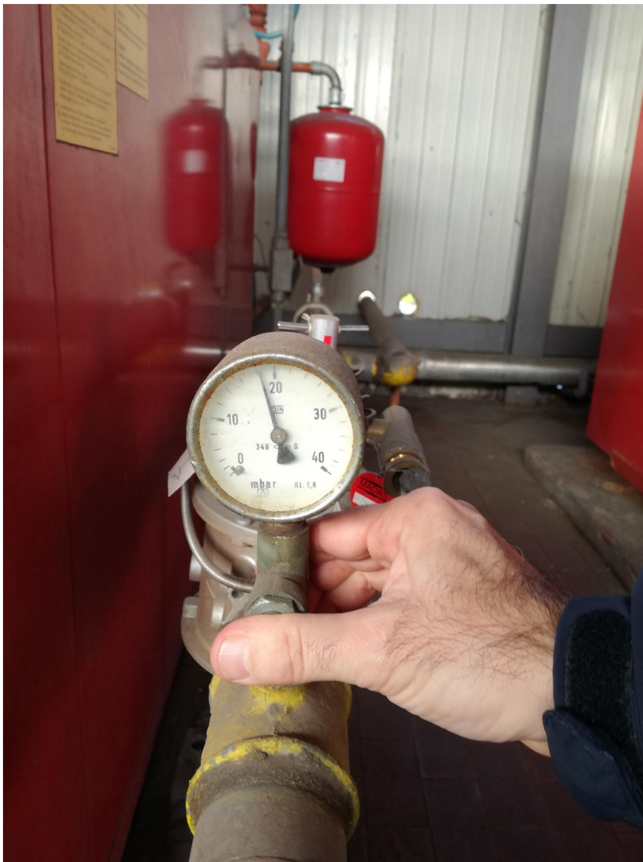
Figura 29 – Pressione utile metano alla rampa gas con caldaia in funzione (19,1 mBar)
