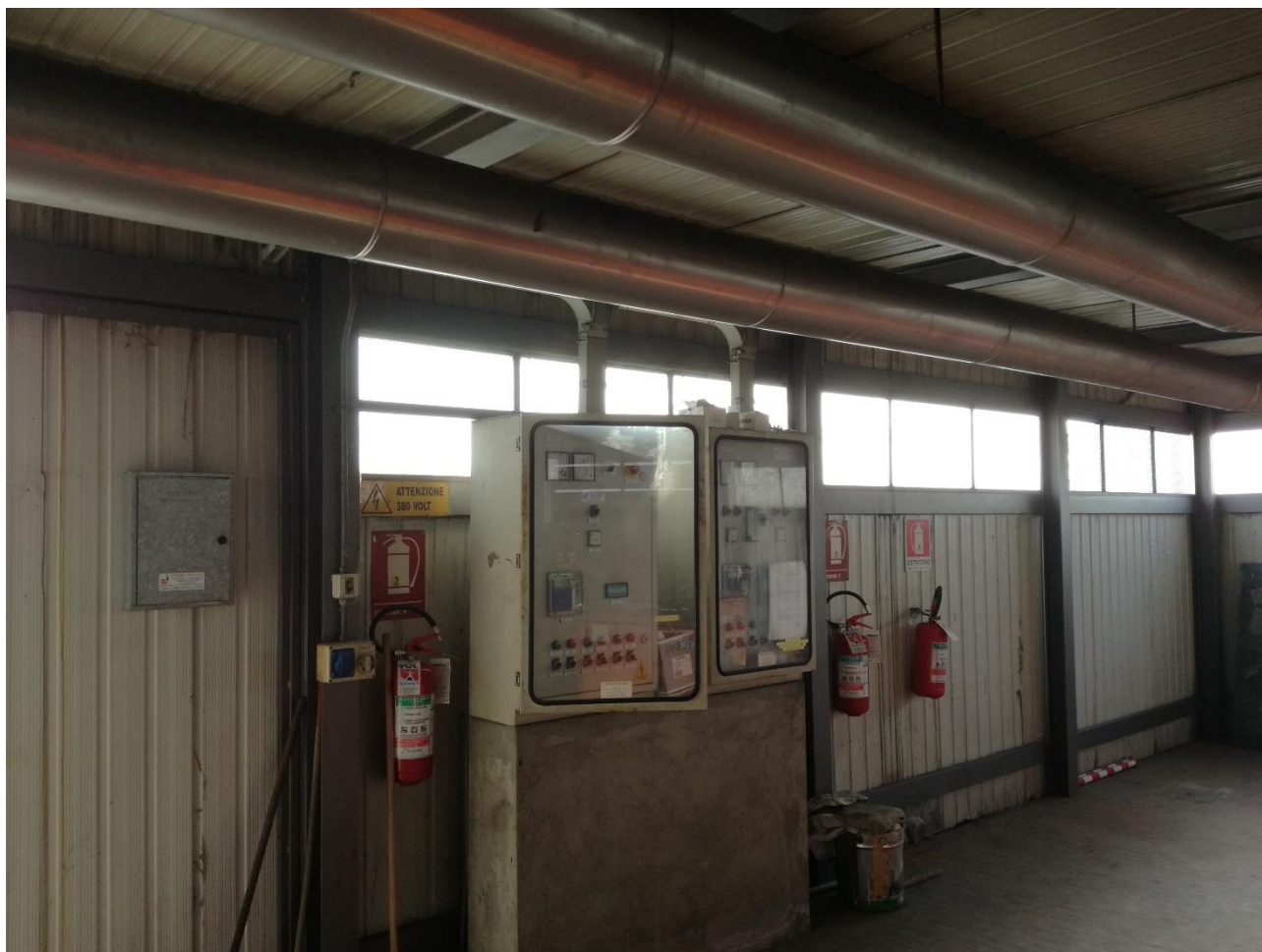
Figura 31 – Attuale quadro elettrico di centrale (potenza e regolazione)
