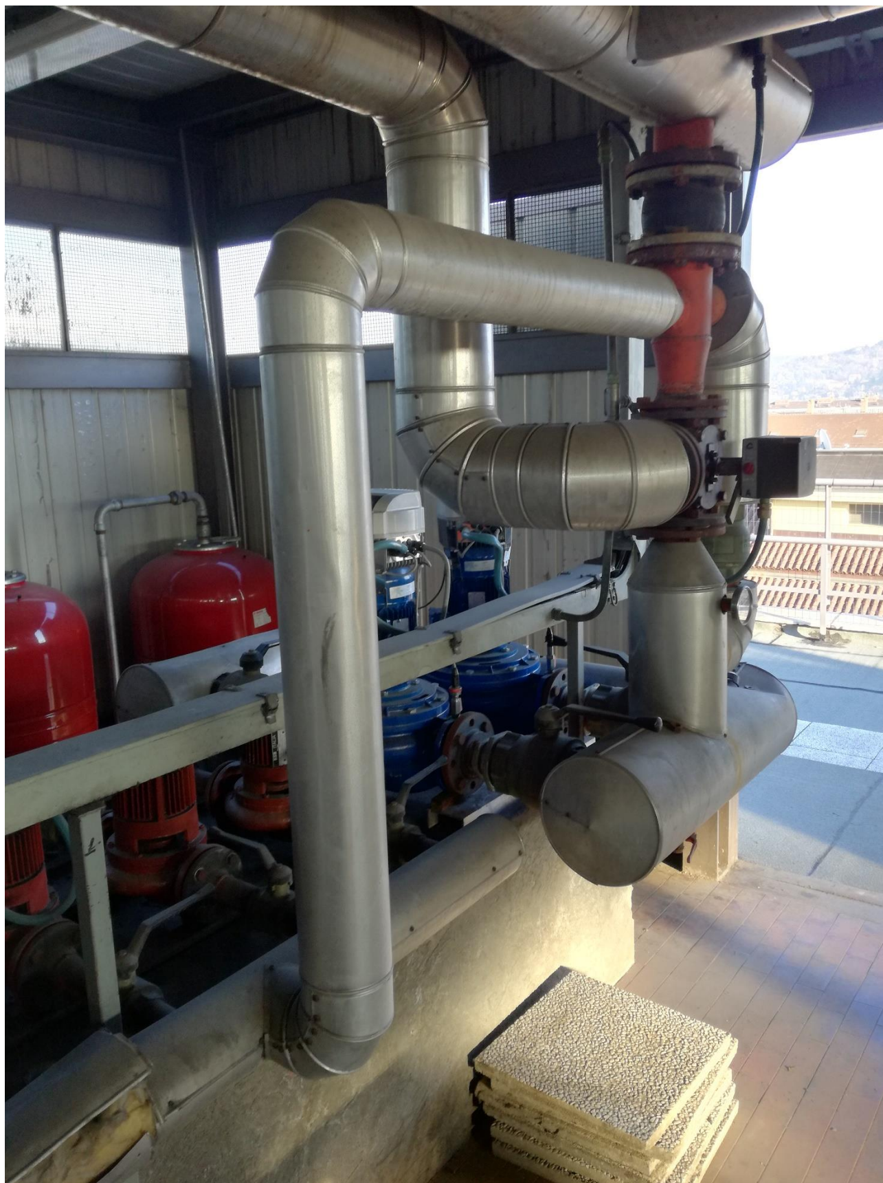
Figura 26 – Valvola a tre vie a servizio circuiti miscelati edificio Via Arsenale 14
