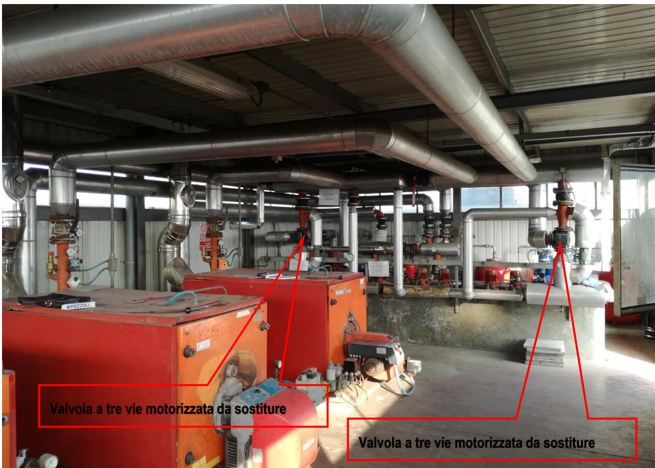
Figura 12 – Valvole a tre vie motorizzate da smantellare e sostituire con valvole di uguali caratteristiche.
