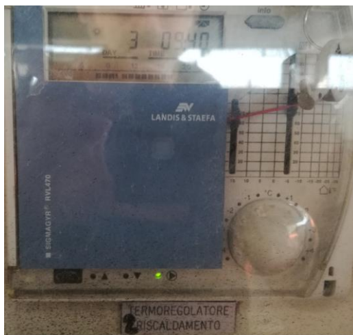
Figura 18 – Vecchio regolatore con curva climatica (Edificio Via Arsenale 14) da programmare nella logica a controllo della nova centrale
