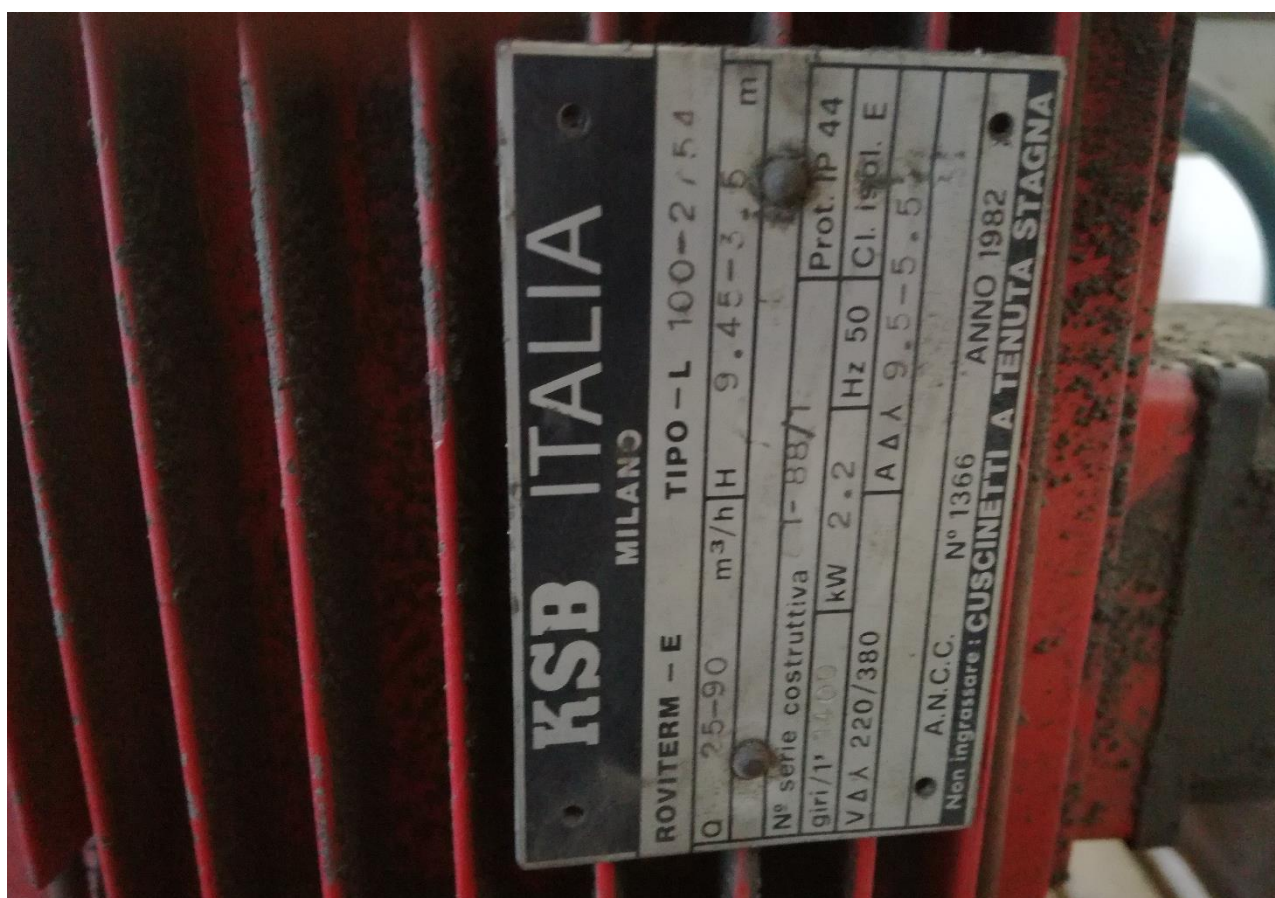
Figura 28 – Gruppo pompe a servizio circuiti miscelati Via Arsenale 14
