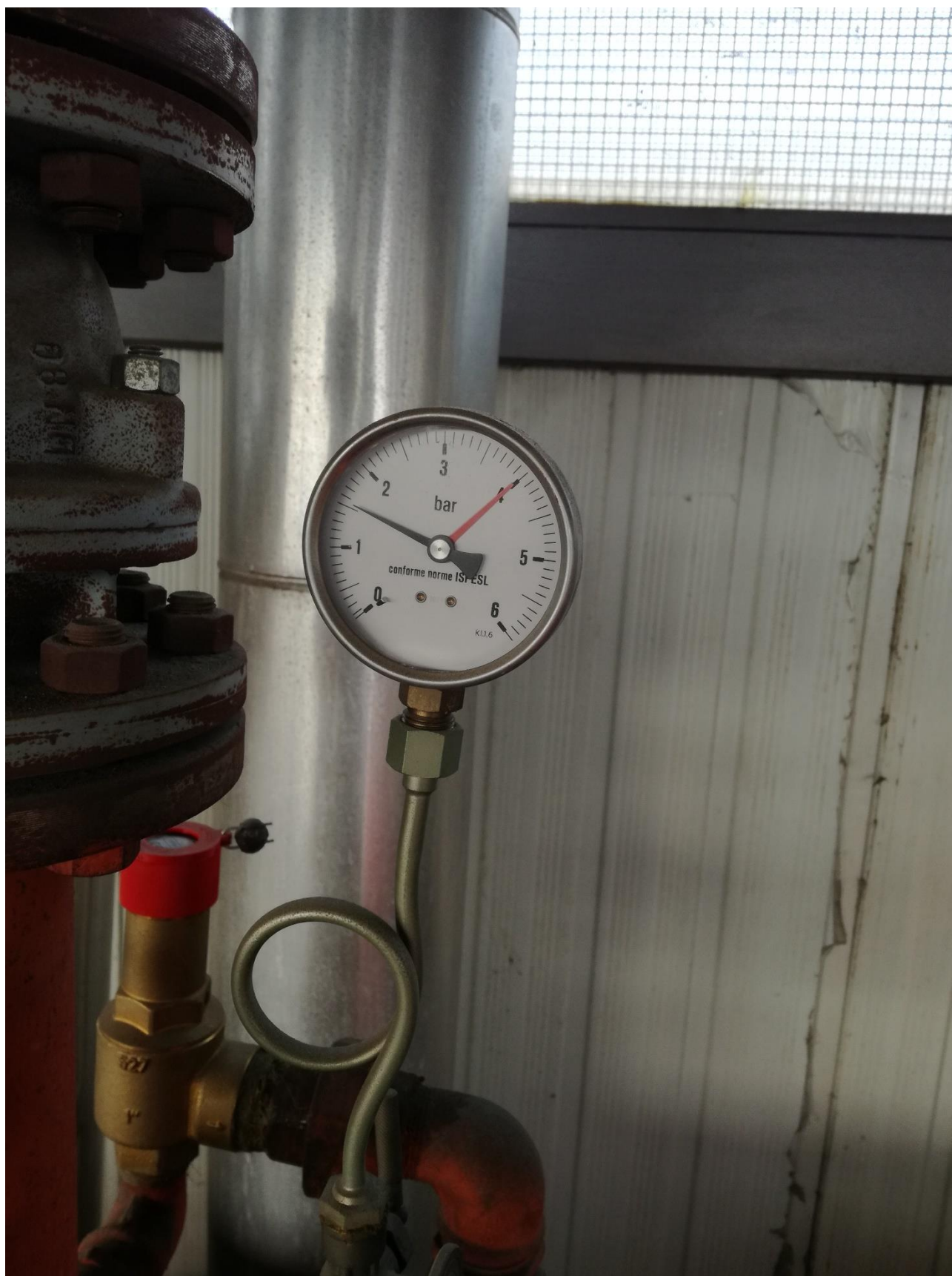
Figura 30 – Pressione precarica impianto attuale 1.5 Bar
