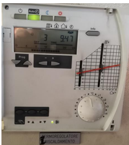
Figura 19 – Vecchio regolatore con curva climatica (Edificio Via Arsenale 12) da programmare nella logica a controllo della nova centrale
