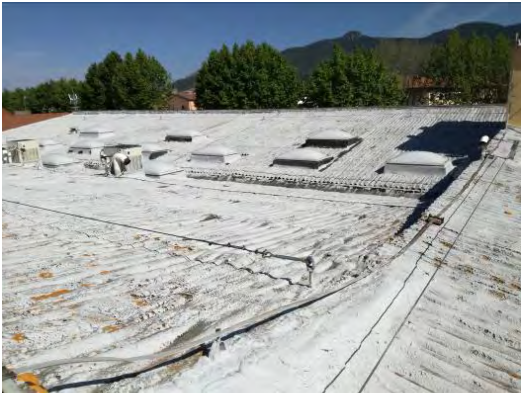
Copertura in cemento amianto incapsulata, lucernari, linea vita esistente
