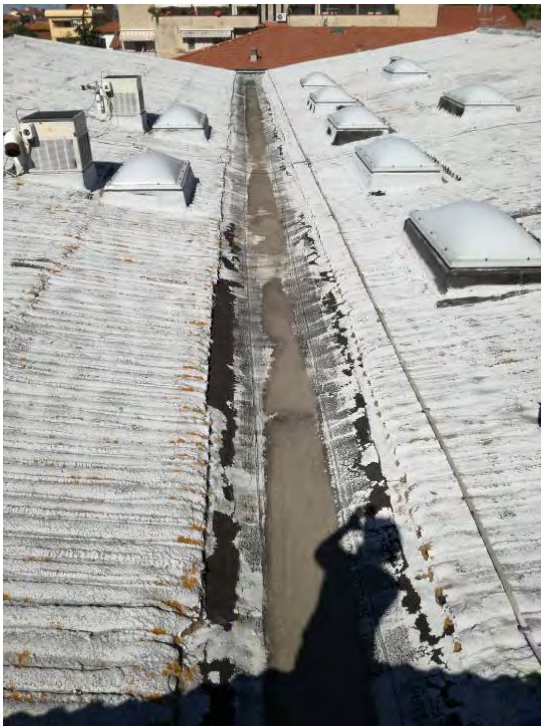
Particolare canale di gronda centrale
