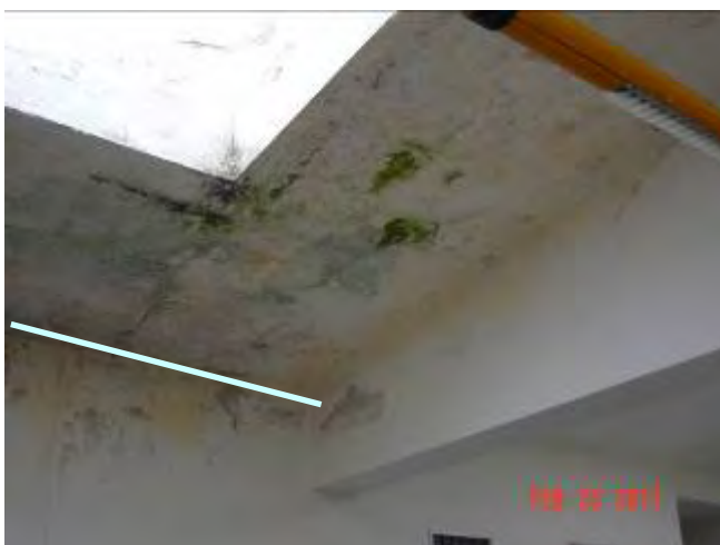
infiltrazioni dalla copertura – formazione estesa di muffe – in evidenza la linea di compluvio della copertura
