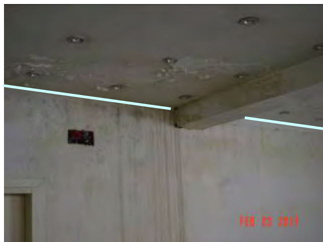
infiltrazioni dalla copertura – formazione estesa di muffe – in evidenza la linea di compluvio della copertura
