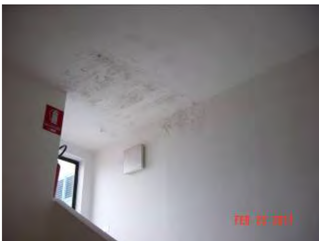
infiltrazioni dalla copertura – formazione estesa di muffe – in evidenza la linea di compluvio della copertura
