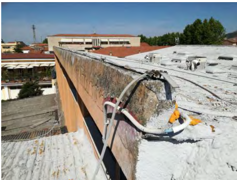
Particolare muretto perimetrale con sovrastante impianto parafulmine
