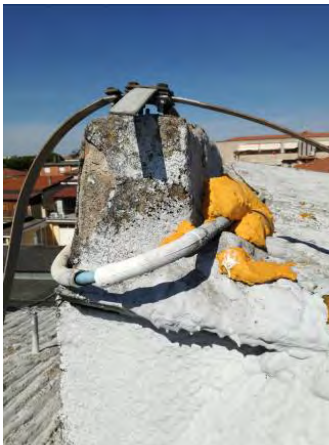
Particolare muretto perimetrale con sovrastante impianto parafulmine
