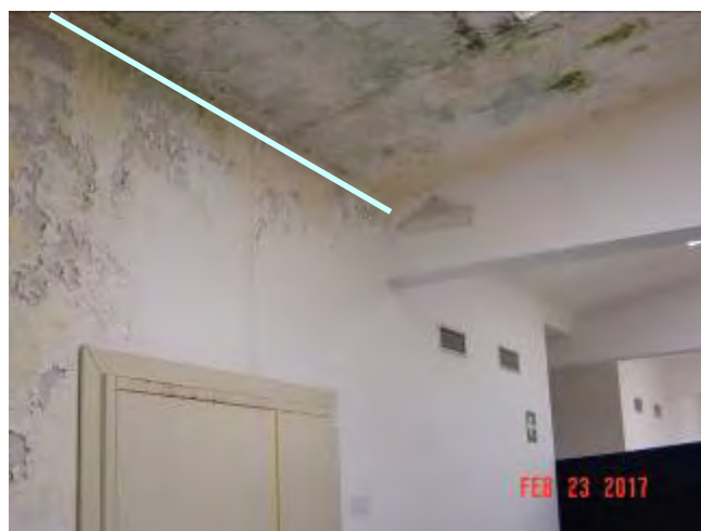
infiltrazioni dalla copertura – formazione estesa di muffe – in evidenza la linea di compluvio della copertura
