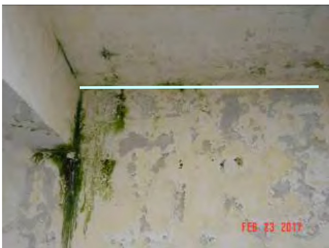
infiltrazioni dalla copertura – formazione estesa di muffe – in evidenza la linea di compluvio della copertura
