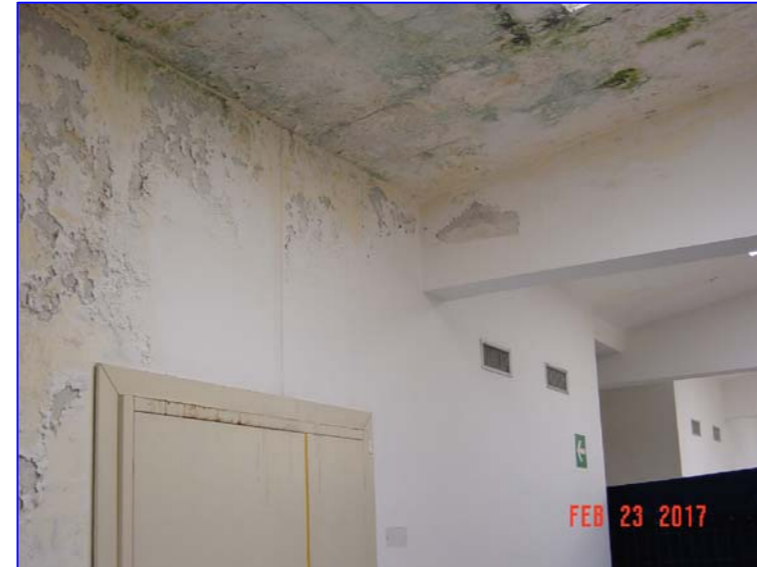
Particolare di infiltrazioni all'interno dai locali provenienti dalla copertura da sostituire
