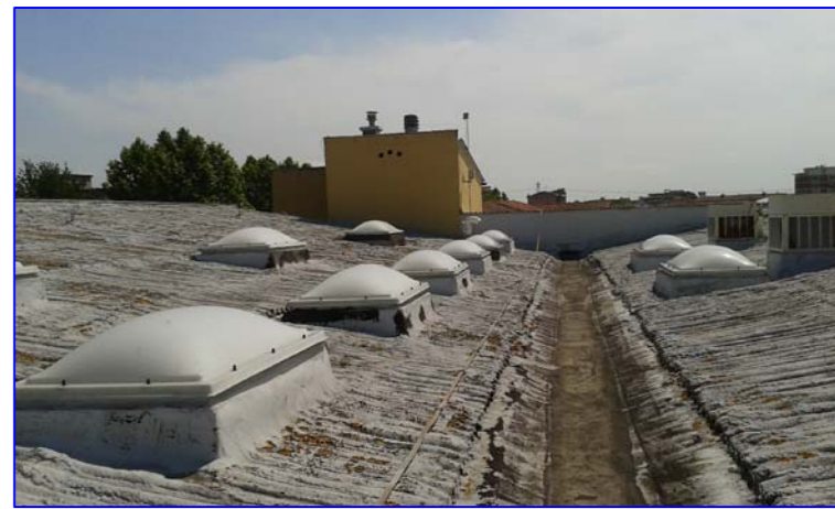
Particolare del canale centrale di compiuvo delle falde di copertura
