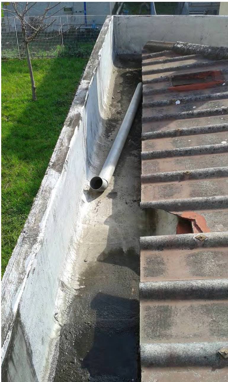
Fig. 11 – Particolare dell'interno del canale di gronda in C.A.
