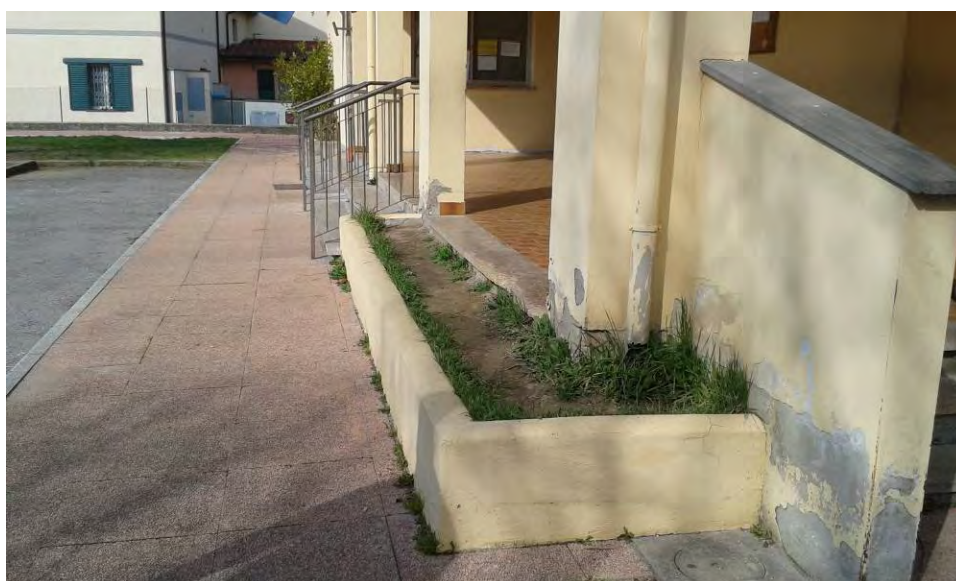
Fig. 6 – Particolare prospetto Sud edificio – in evidenza le fioriere in muratura da togliere
