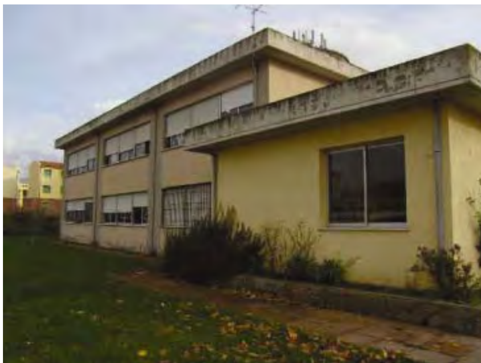
Fig. 5 – Vista prospetto Ovest edificio – in evidenza le fioriere in muratura da togliere e le gronde in C.A.
