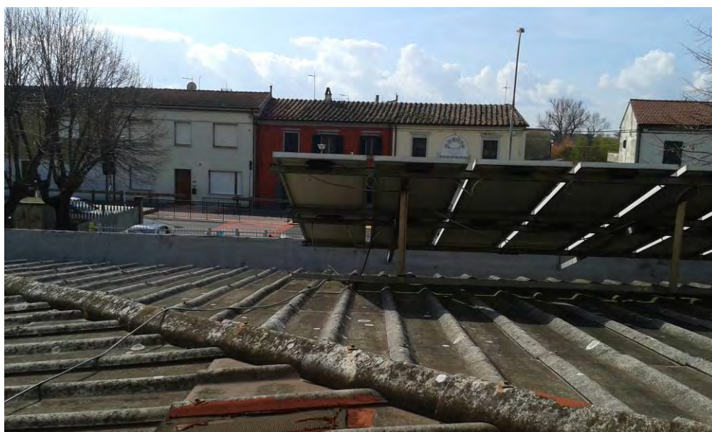
Fig. 10 – Particolare dello stato di usura della copertura in m.c.a.
