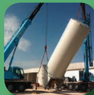
sistemi di pompaggio
