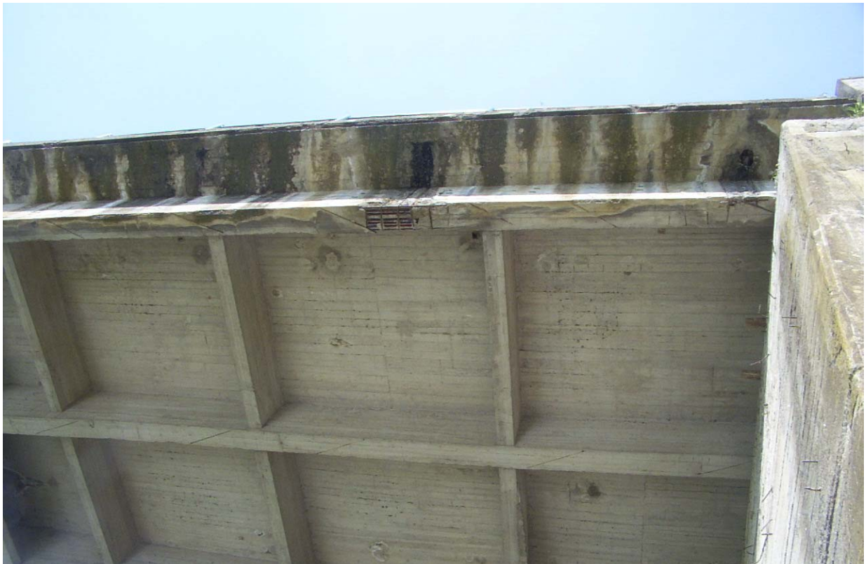
Dettaglio dell'impalcato con evidenza dello stato di degrado
