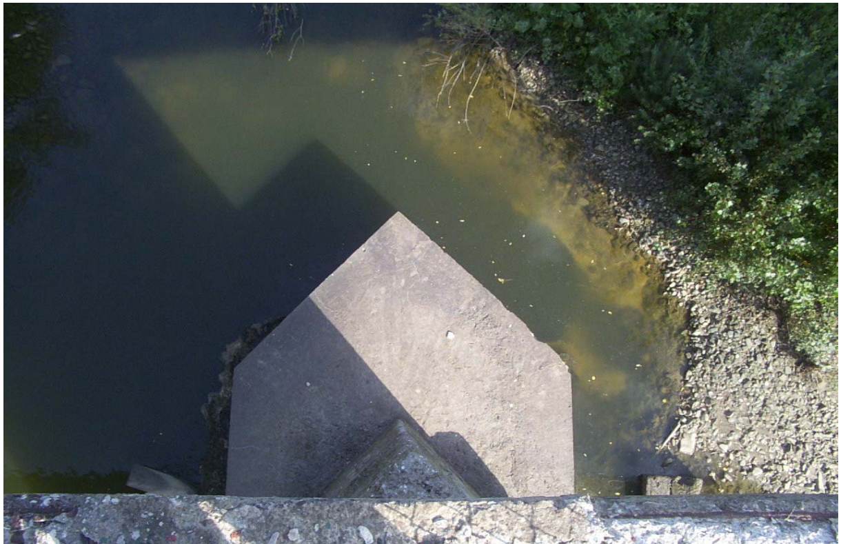
Dettaglio della formazione frangi onde dello zoccolo della pila
