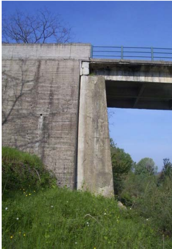
Dettaglio dell'innesto spalla-muri andatori
