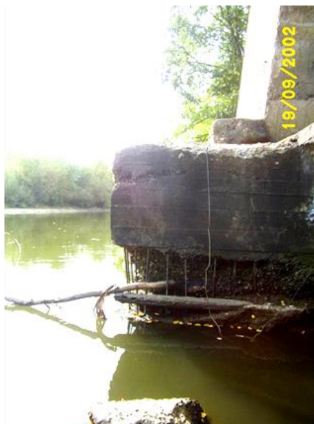
Figura 4: particolare del piede di una pila del Ponte Catolfi, soggetto a fenomeni di scalzamento.
