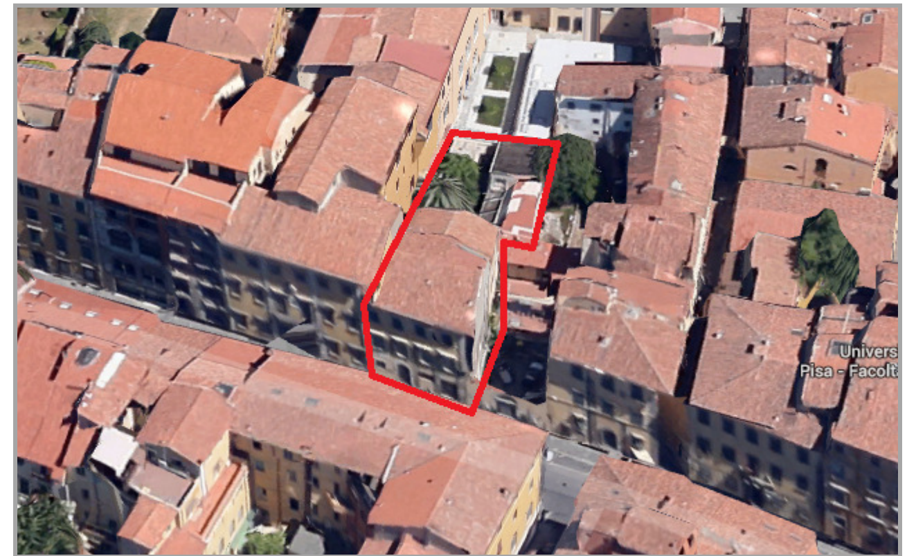
Fig. 1- foto aerea dell'edificio prospetto via S. Maria
