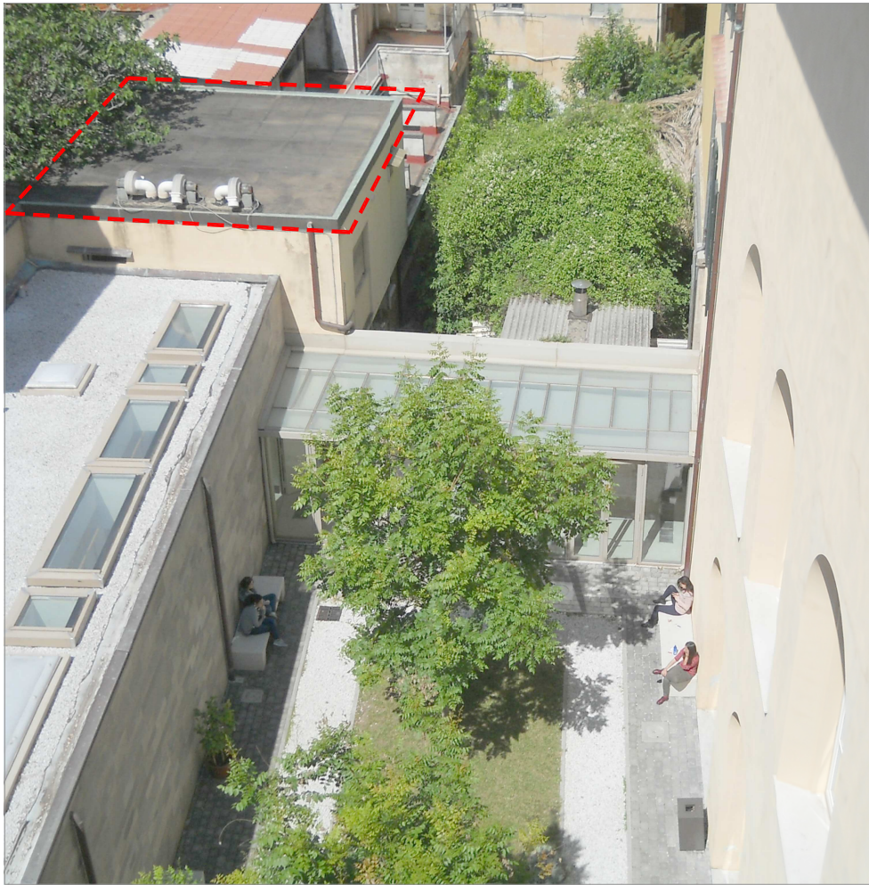
Foto 1 - Copertura piana lato corte interna oggetto dell'intervento
