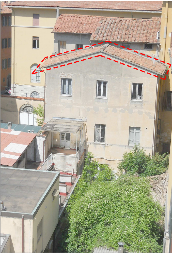
Foto 1 - Copertura a capanna lato giardino interno oggetto dell'intervento
