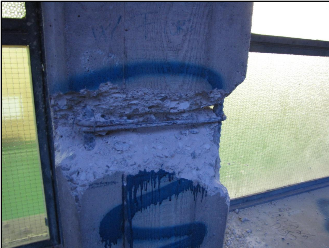
Foto 6 - Armatura presente su un pilastro
