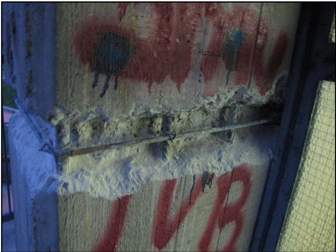
Foto 4 - Armatura presente su un pilastro
