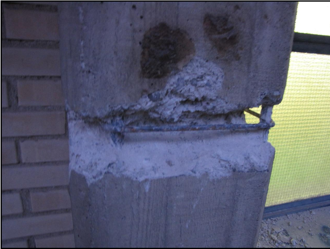
Foto 5 - Armatura presente su un pilastro
