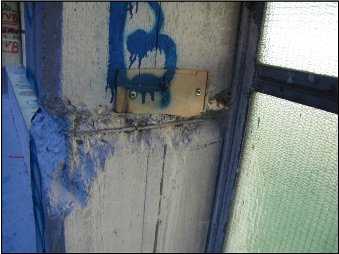
Foto 7 - Armatura presente su un pilastro
