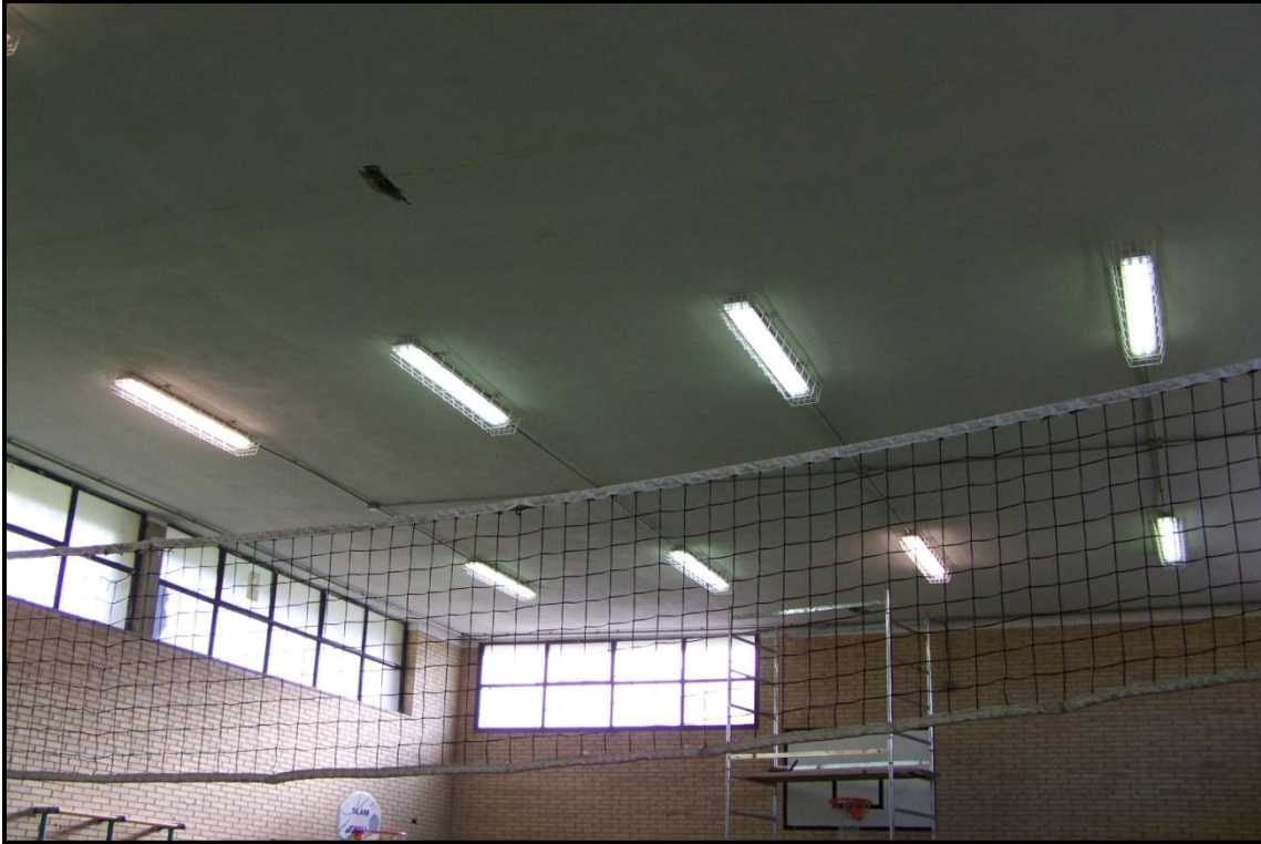
Foto 1 - Vista d'insieme dei saggi sulle travi di copertura
